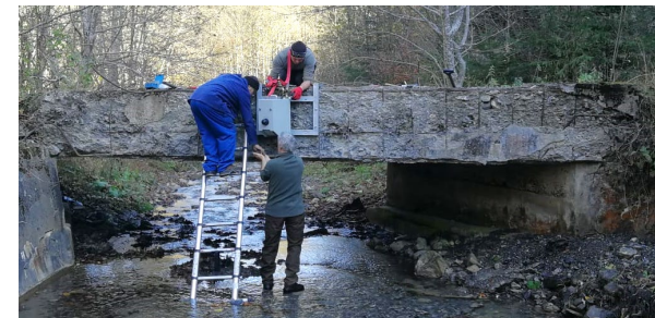
Instalare RQ-30 Discharge Radar (pentru modelare și simulare hidrologică) PN 23 09 02 03
